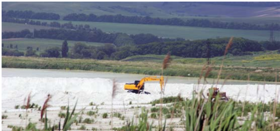
Бывший ГМЗ. НПО Алмаз Реабилитационные работы на хвостохранилище. г. Лермонтов. Ставропольский край
