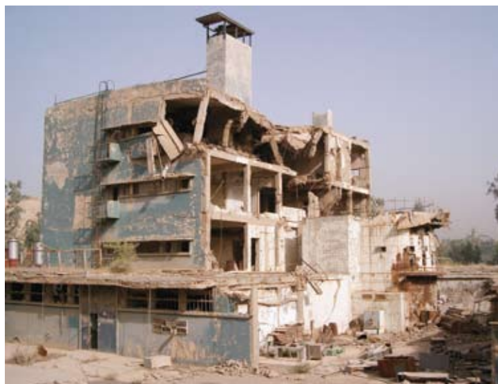
Разрушенное здание исследовательского реактора IRT-5000, Ирак
