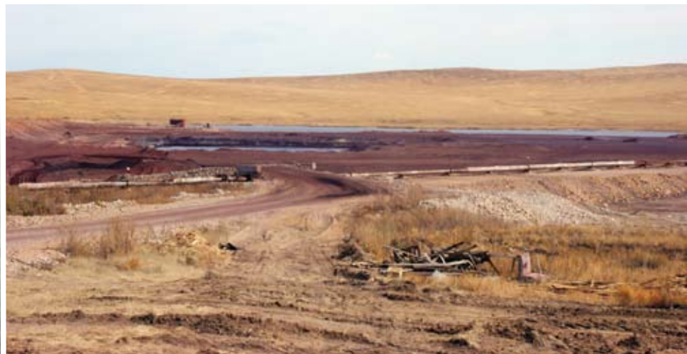
Хвостохранилище. ППГХО, г. Краснокаменск
